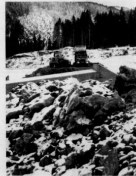
Her er det anlegget av tilstøtende veg til Skarnsundbrua på Indersøy-sida. Arbeidet ligger framfor tidsplanen.
