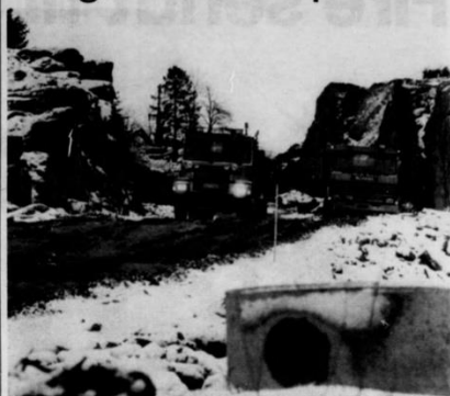
Store lastebiler blir brukt til å transportere steinmassene fra skjeringa og til vegen lenger fram mot fjorden.
